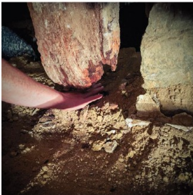
Pilar podrido y en vuelo en medianera con el número 43 en planta baja.
