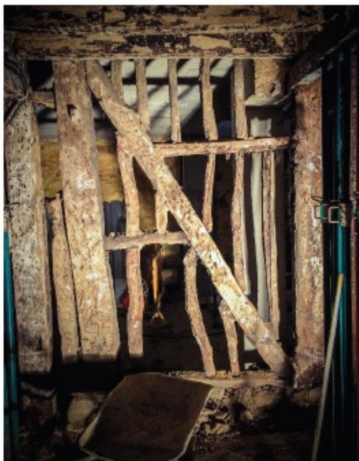
Entramado de madera de la medianera con el número 43.
